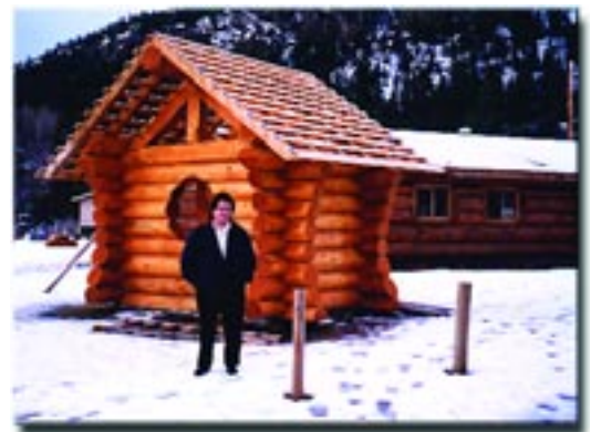
Construction de maisons en rondins pour le développement et la formation en affaires – bande Nooaitch.
