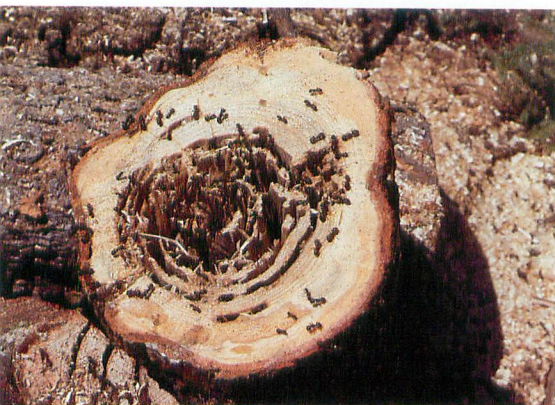
Fig. 5-1. Ravages causés par les fourmis charpentières.
