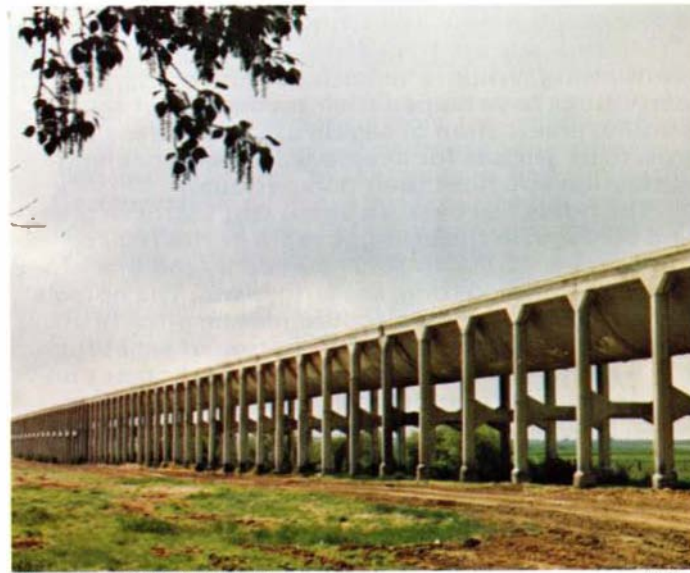
Tillev aqueduct (R. E. Stevenson)
