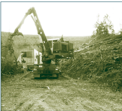
Opération de déchiquetage des résidus forestiers (Dégelis, Québec). Photo : E. Thiffault (SCF)
