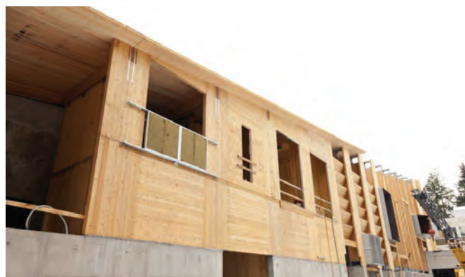
Panneaux de BSC utilisés dans la construction de l'installation de recherche et de démonstration sur la bioénergie de l'Université de la Colombie-Britannique. Photo gracieuseté de KK Law Photography
