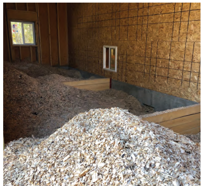
Des copeaux de bois sont utilisés comme combustible dans des chaudières à biomasse pour chauffer dix bâtiments communautaires.
